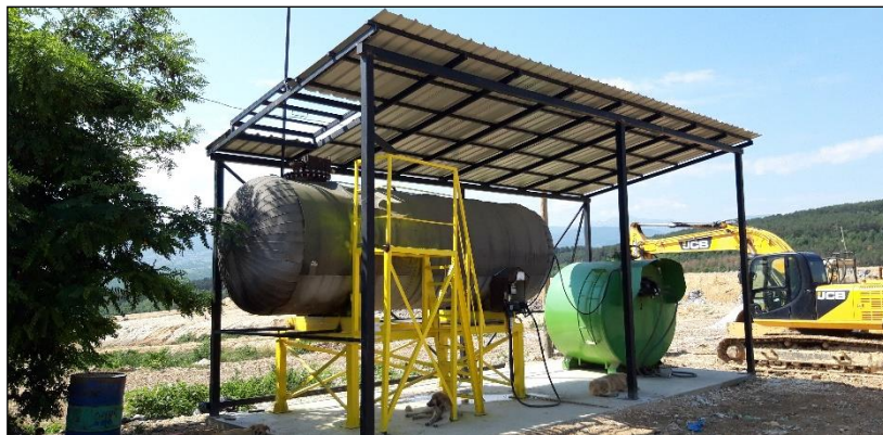
Слика бр. II-24: Бензиска пумпа со резервоар
