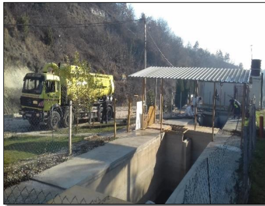
Слика бр. II-23: Вадење талог од резервоар
