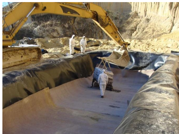
Слика бр. II-18: Изграба на депонија за азбест Слика бр. II-19: Депонирање на азбест
